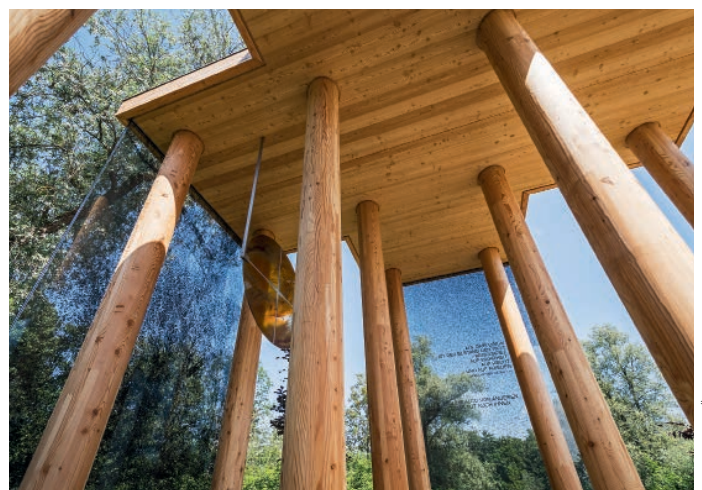
▲ Die Kapelle von Architekt Hans Engel hat einen kreuzförmigen Grundriss. Zwölf gedrechselte Rundsäulen aus Lärchenholz tragen ein Holzdach
